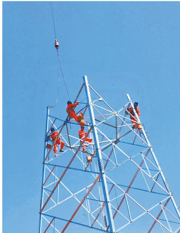
8月9日,吉安市吉州区兴桥镇西气东输吉安联络站110千伏外部供电线路工程现场,电力施工人员冒着高温进行铁塔组塔作业。该项目线路总长度约32千米,建成后可提高沿线区域冬季供电保障能力。
