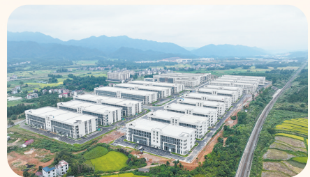
井冈山市碧溪产业园标准化厂房
