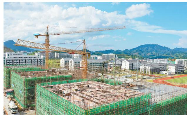
近日,在安远县产城新区电子信息产业园标准厂房二期项目现场,工人顶着烈日进行水泥浇筑、模板安装、钢筋绑扎等作业。该项目建成后将提升安远县产城新区的承载力,为园区招商引资、产业集群发展提供强力支撑。
