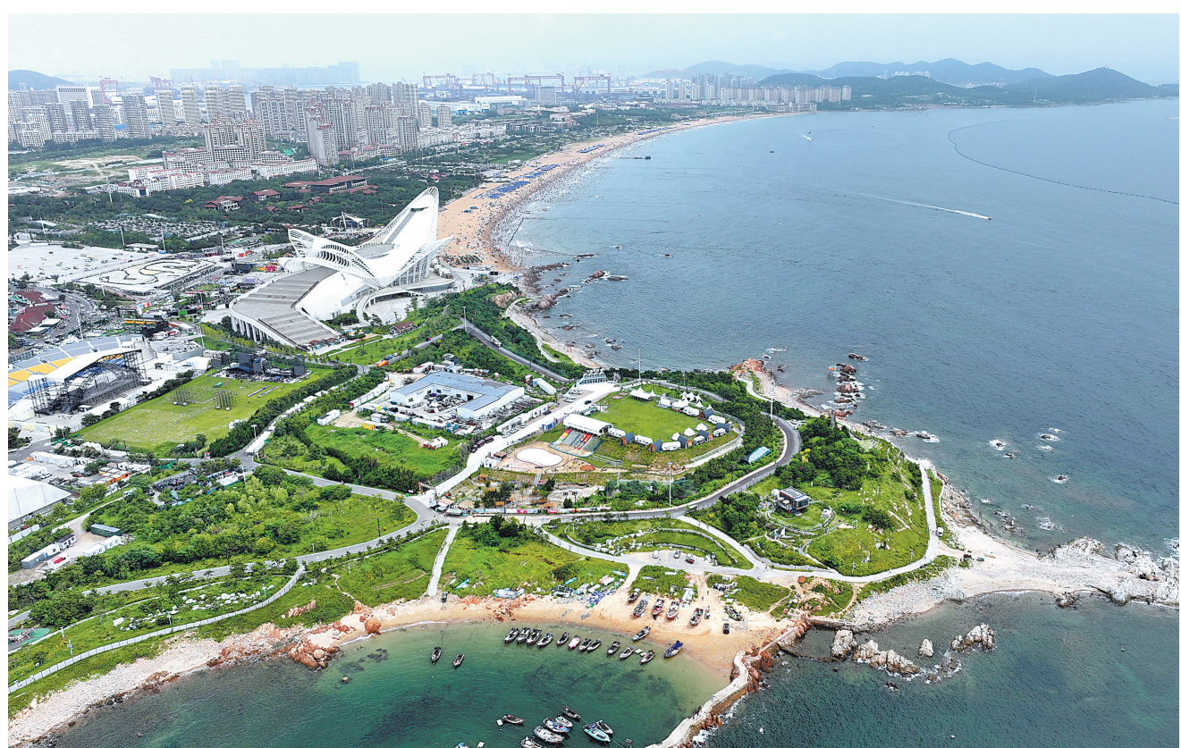
▲这是青岛西海岸新区“蓝湾漫道”金沙湾段。山东省近年来通过修复整治生态岸线项目，还城市一条“蓝腰带”；配套建设城市书房、海洋美术馆等文化设施，还市民亲海、休闲空间，让海滨城市飘扬起生态“绿丝带”。新华社记者 李紫恒摄
