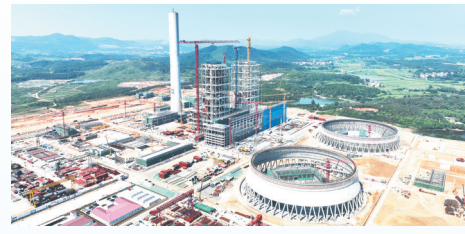
上高清洁煤电项目建设现场
