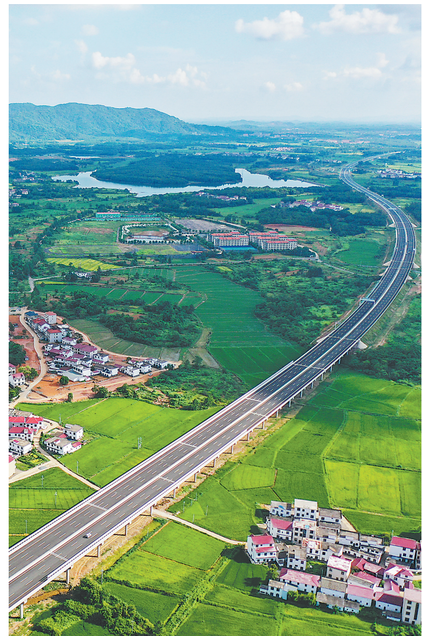
8月19日,南昌西二绕城高速公路(厚田—石鼻段)正式开通运营。该段高速公路的开通运营,将东西向的沪昆高速与杭长高速、昌栗高速有效连接起来,形成更为完善的城市交通格局,可以更好地满足沿线群众的出行需求,缓解城市内环交通压力。
