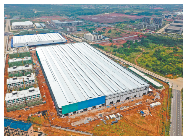
8月15日,吉安市吉州区伊戈尔股份第三代数字供电系统百亿项目正有序推进。目前,主体施工已完成,正在进行砌筑工程施工,项目一期预计12月竣工。 本报全媒体记者 吴文兵摄
