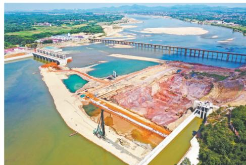
8月17日，金溪县浒湾镇疏山水利枢纽工程施工现场，施工人员正在加紧施工。疏山水利枢纽工程总投资11.107亿元，是以灌溉、供水为主，兼顾发电、航运、改善水环境等综合效益的中型工程。
