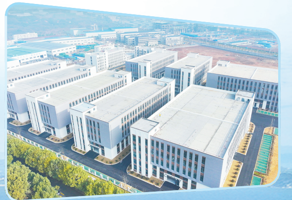
濂溪产业园滨湖片区标准化厂房二期项目
