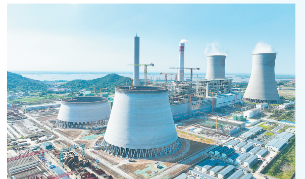
重点工业项目加紧建设
