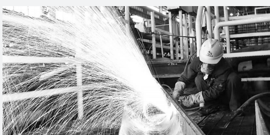
工人正聚精会神地开展检修
