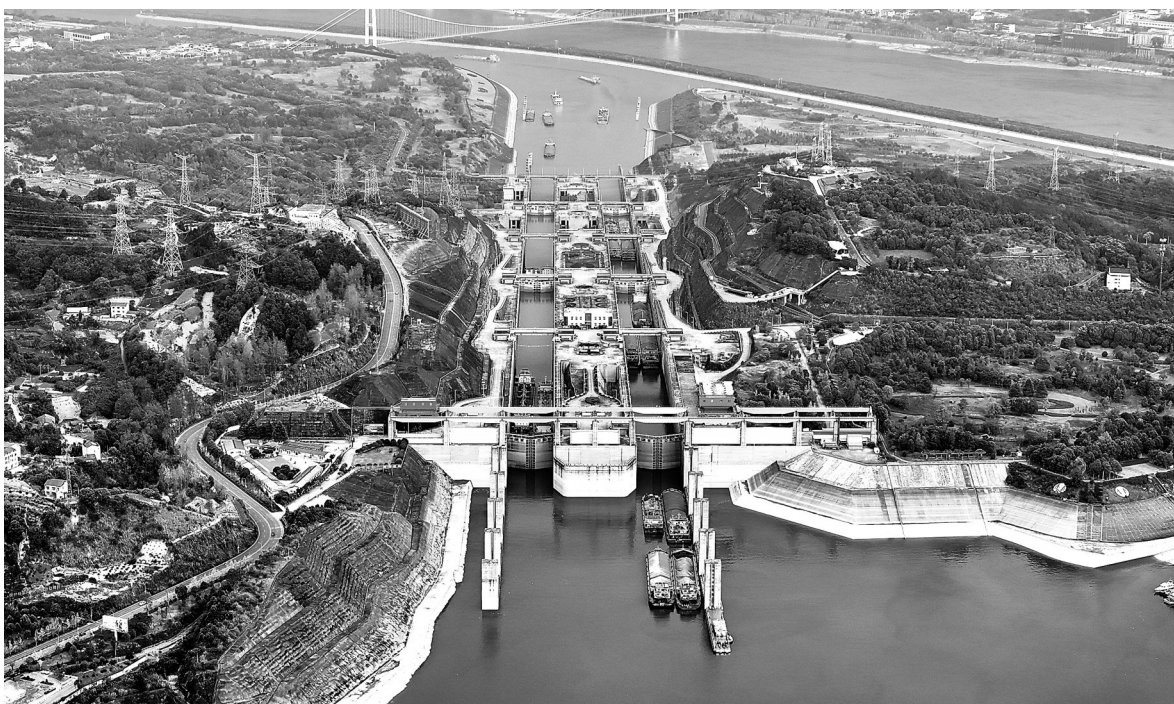
三峡船闸今年过闸货运量突破1亿吨
