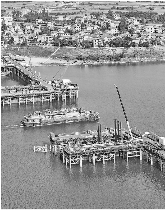
10月6日,南昌县昌南大桥项目建设现场,工人正加紧施工。昌南大桥建成后,将推动向塘国际陆港、小蓝经开区、姚湾综合码头等重要板块互联互通,深化城市东西向协同发展。 本报全媒体记者 史港泽摄
