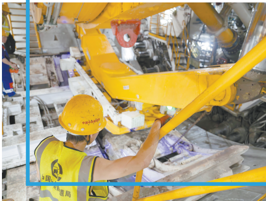
▲在上海沪渝蓉高铁崇太长江隧道施工现场，“领航号”盾构机进行管片吊装作业。
