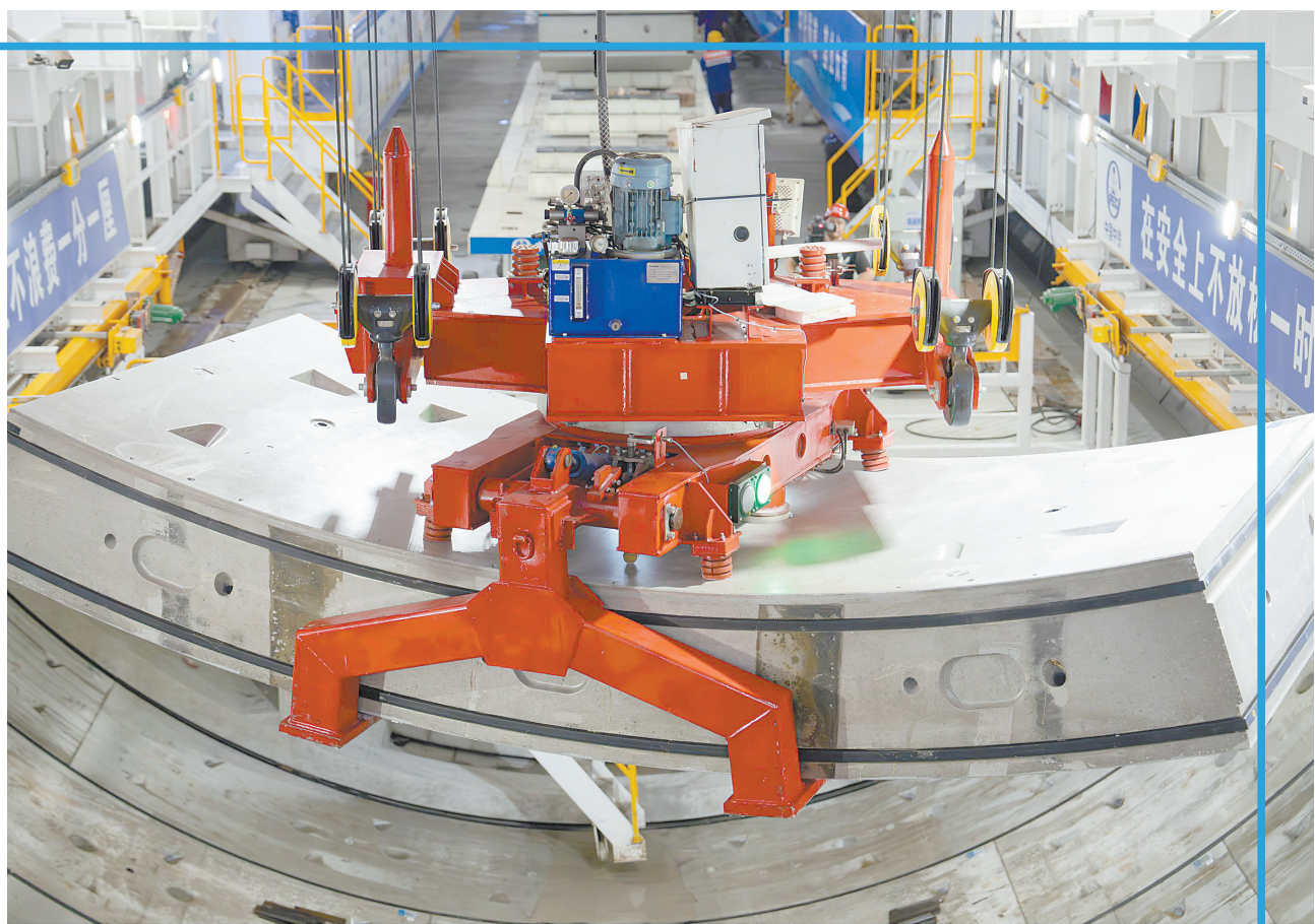
▲在上海沪渝蓉高铁崇太长江隧道施工现场，“领航号”盾构机进行管片吊装作业。
