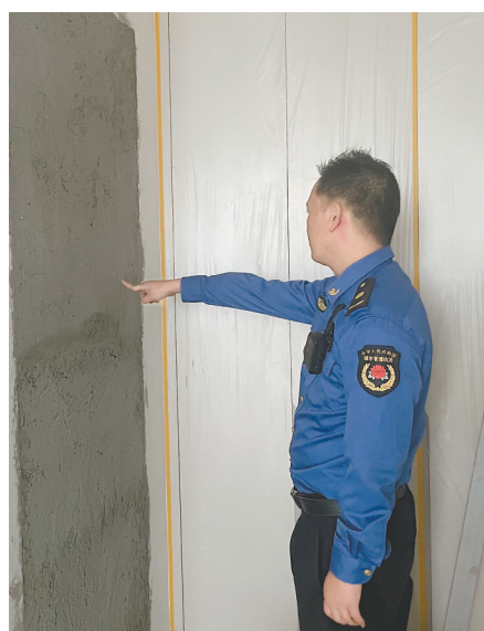
城管执法人员带记者看被封住的电梯井与搭建楼层入口。
