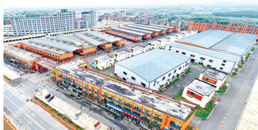
▲江西塑丰科技开发有限公司丰城市汇金国际电商产业园一期项目更新改造，打造完整的鞋业产业链，已入驻鞋商以及相关配套企业89家，园区工人约3000人，日产值达60万元。
