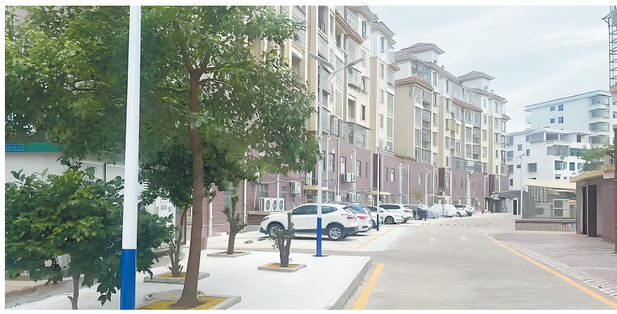
改造后的华源城市广场焕然一新
