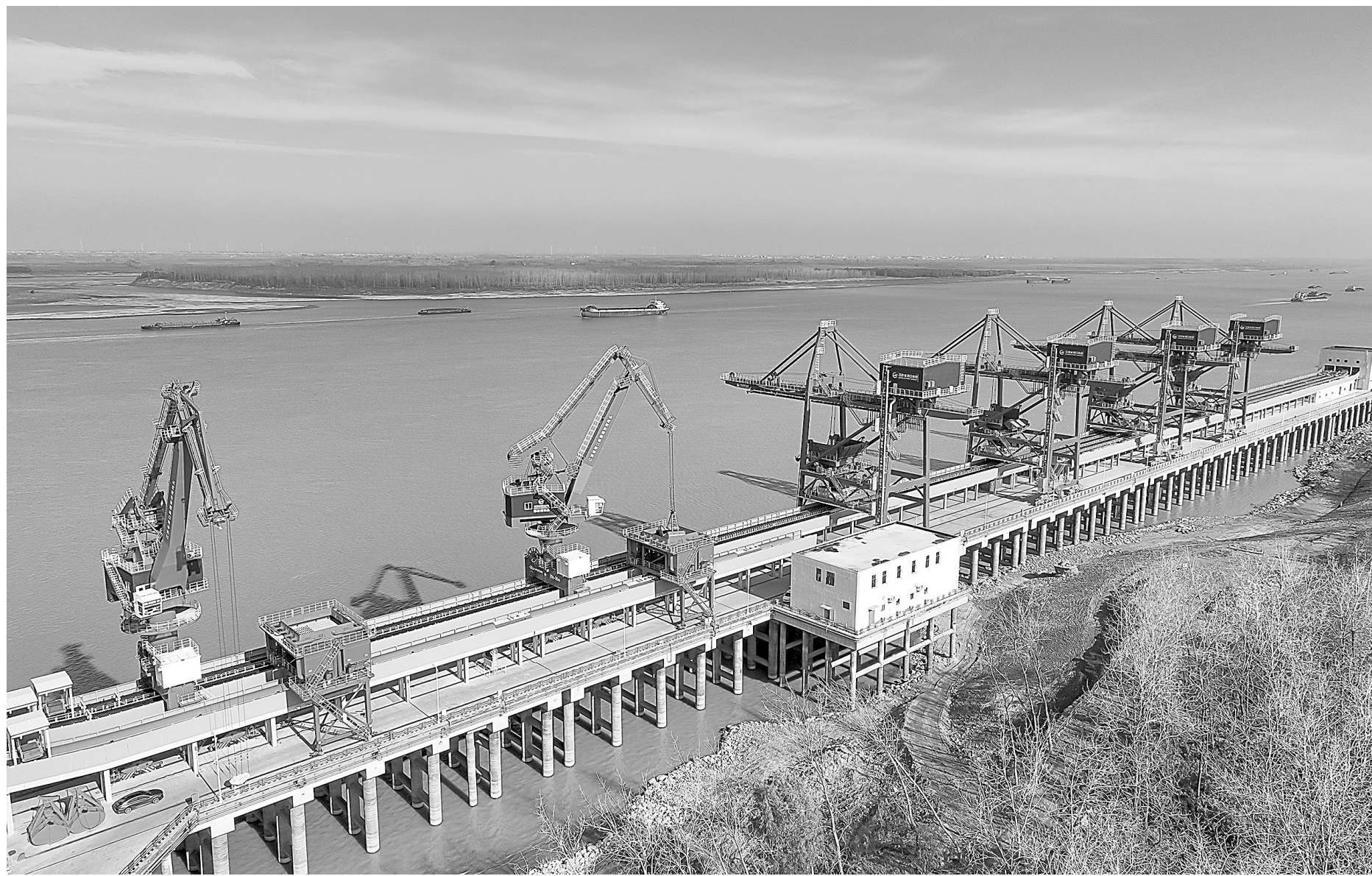
全力推进综合码头建设
