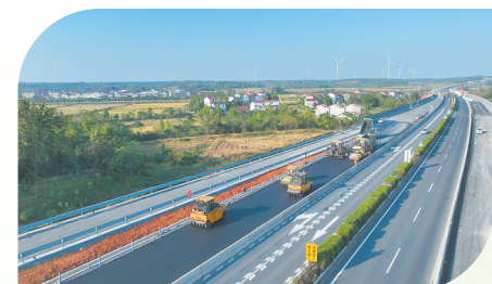
樟吉改扩建项目新建路面施工现场
