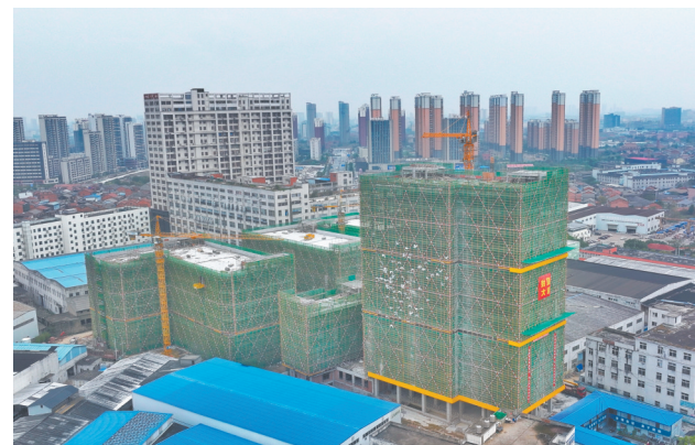
11月20日,南昌市青云谱新经济产业园标准厂房和配套工程项目正在如火如荼建设中。该项目通过盘活低效用地约30亩,推动产业集聚发展。 本报全媒体记者 王蕴蓉摄
