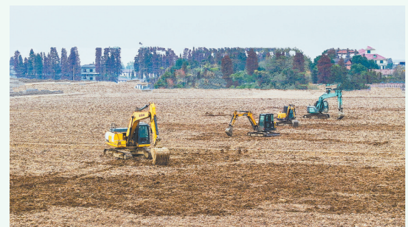
12月17日,在南昌县塘南镇新联村高标准农田建设项目现场,挖掘机正在挖土、整地。自2017年以来,塘南镇累计建成高标准农田5.48万亩,2024年新联村新建高标准农田5600余亩。 通讯员 曾灵摄
