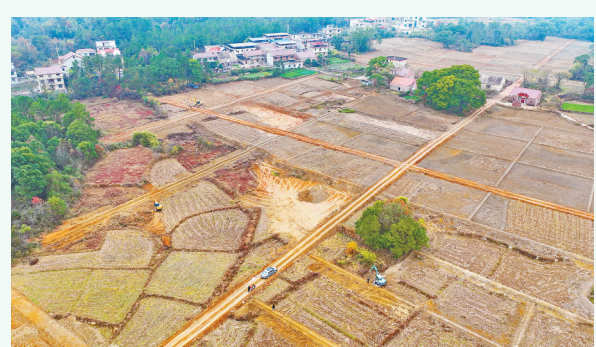
12月15日,在吉安县万福镇大杏村高标准农田建设项目施工现场,几台挖掘机正在平整土地、开挖沟渠。当地通过改善农业生产基础条件,有效促进农村土地流转,拓宽农民增收渠道。 通讯员 刘晨摄
