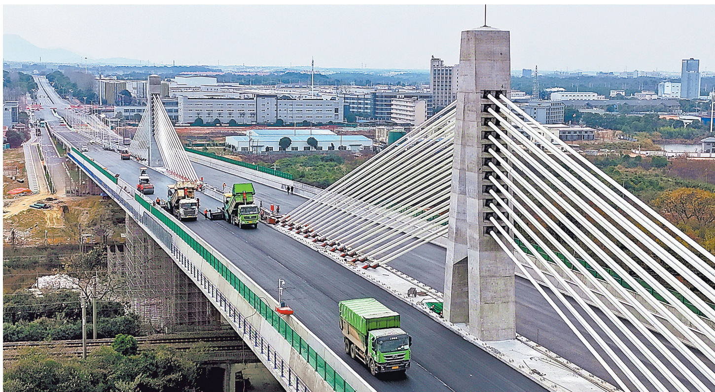
12月22日,在赣江新区新祺周片区阳光大道跨京九铁路和昌九城际铁路转体斜拉桥项目建设现场,工人正紧张有序地进行桥面沥青摊铺施工,标志着大桥建设进入通车前的最后冲刺阶段。
