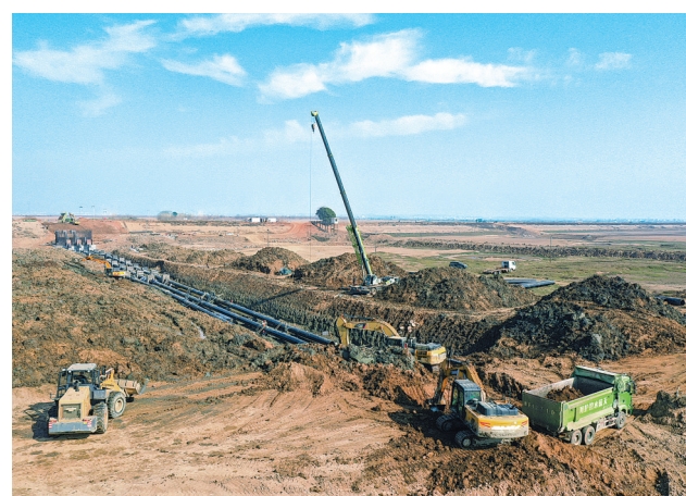
1月20日,余干县瑞洪镇六0灌区提水泵站及灌渠提升改造施工现场一片忙碌景象,工人们抢抓晴好天气加紧施工。
