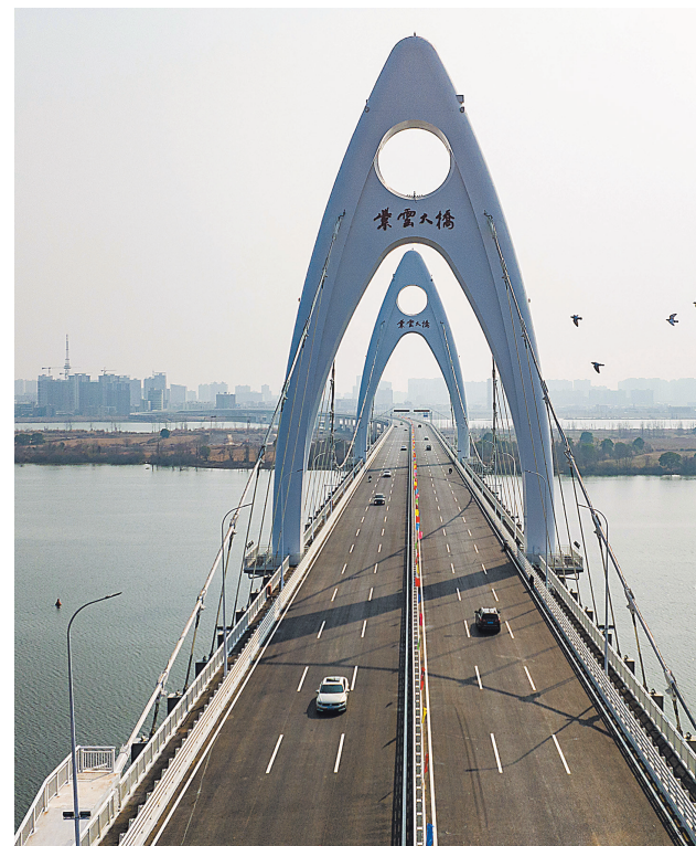
1月23日，丰城市紫云大桥建成通车。紫云大桥是市重点民生工程，为双塔空间双索面钢混组合梁自锚式悬索桥，全长5.5公里，双向6车道。特约通讯员 王 堃摄
