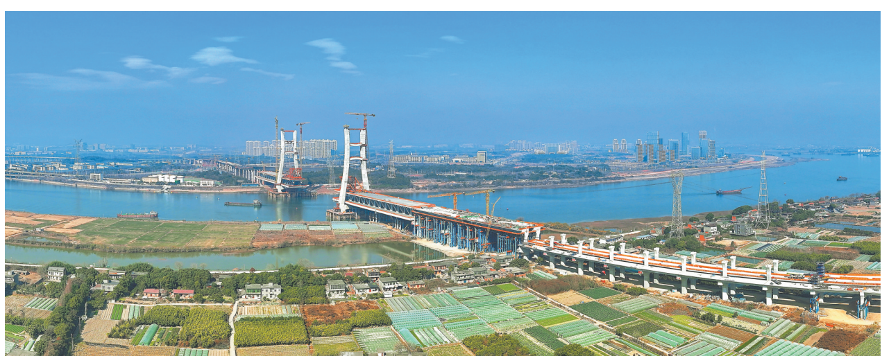
新年伊始,我省各地工程建设现场一派繁忙。由中铁大桥局承建的昌九高铁关键控制性工程隆兴大桥建设现场,大桥西支主桥的两座索塔已封顶,目前正在进行主跨钢梁架设作业。本报全媒体记者 王蕴蓉摄
