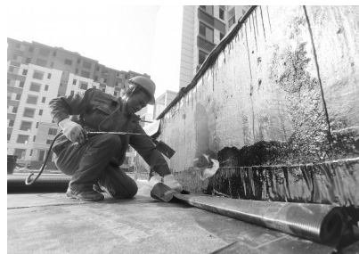
1月29日，安福县棚户区改造项目崇德小区建设工地，工人正在做防水工程。特约通讯员 刘丽强摄
