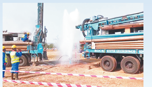
地建投集团水利项目,多哥奥古省乌都镇别村村水井出水现场 刘一从摄
