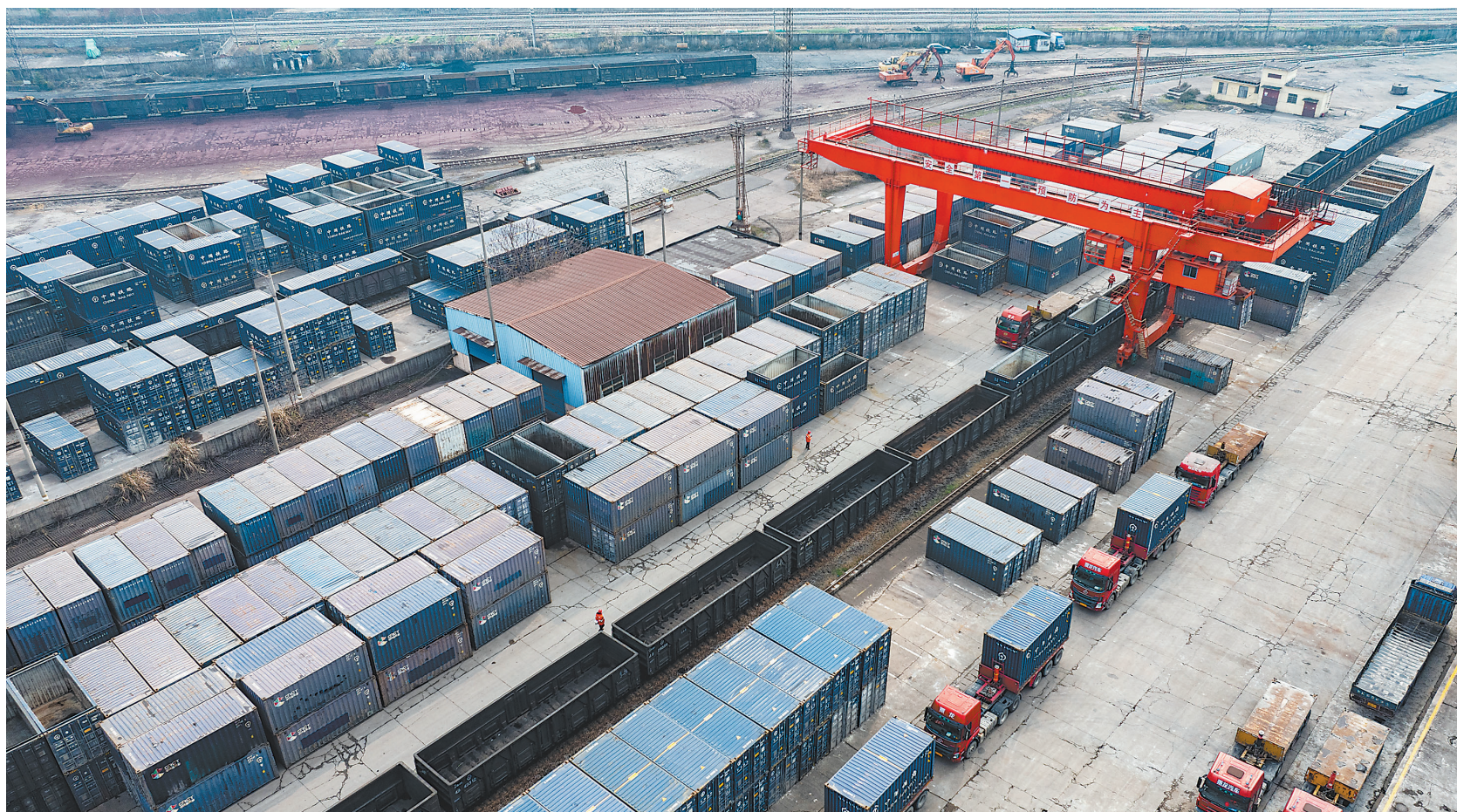
近日，中国铁路南昌局集团有限公司新余铁路货场内，大型吊机对进站货运列车进行高效装卸作业。
