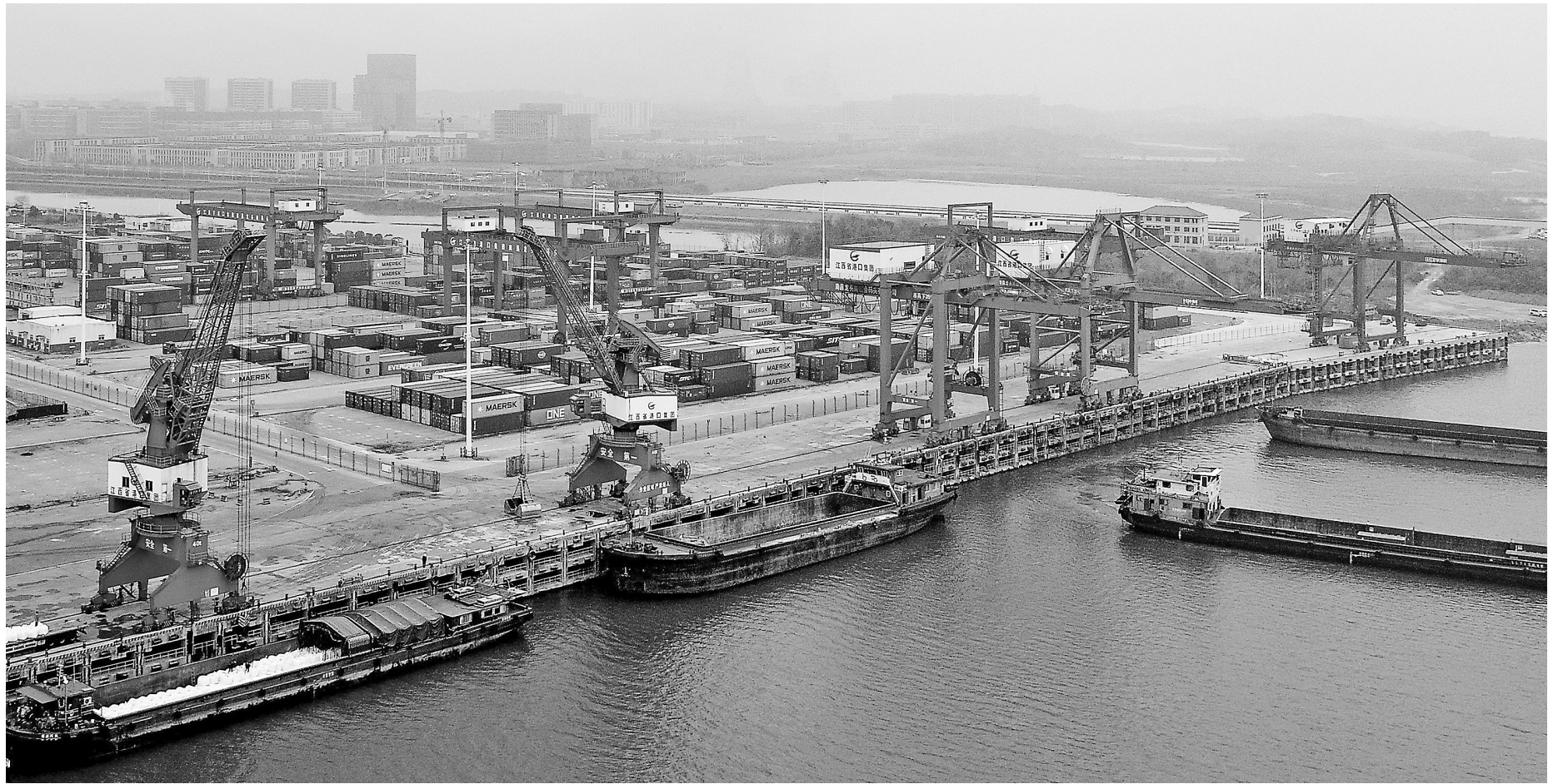
2月25日，位于赣江新区临空组团的南昌龙头岗综合码头，船舶和车辆正在进行装卸作业。
