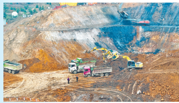
流源水库施工现场。
