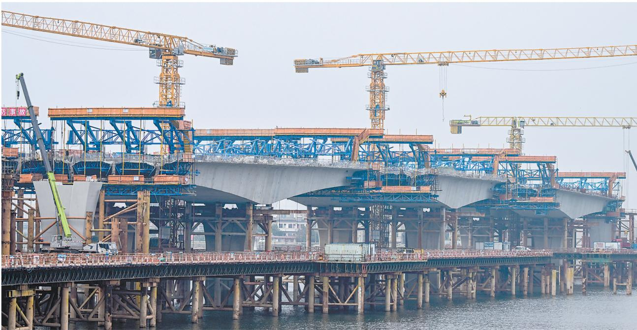
2月27日,南昌市北二环一期(隆兴大桥南及连接线工程)施工现场,工人正有序推进桥梁浇筑架梁作业。
