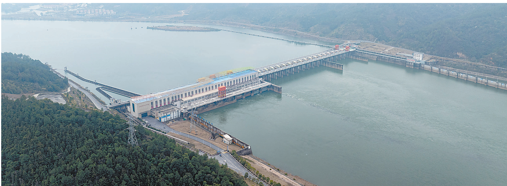
航拍镜头下的峡江水利枢纽工程，雄伟壮观。该工程位于赣江中游峡江县段，是鄱阳湖生态经济区建设的重点水利工程之一，建成后累计发电88.54亿千瓦时。
