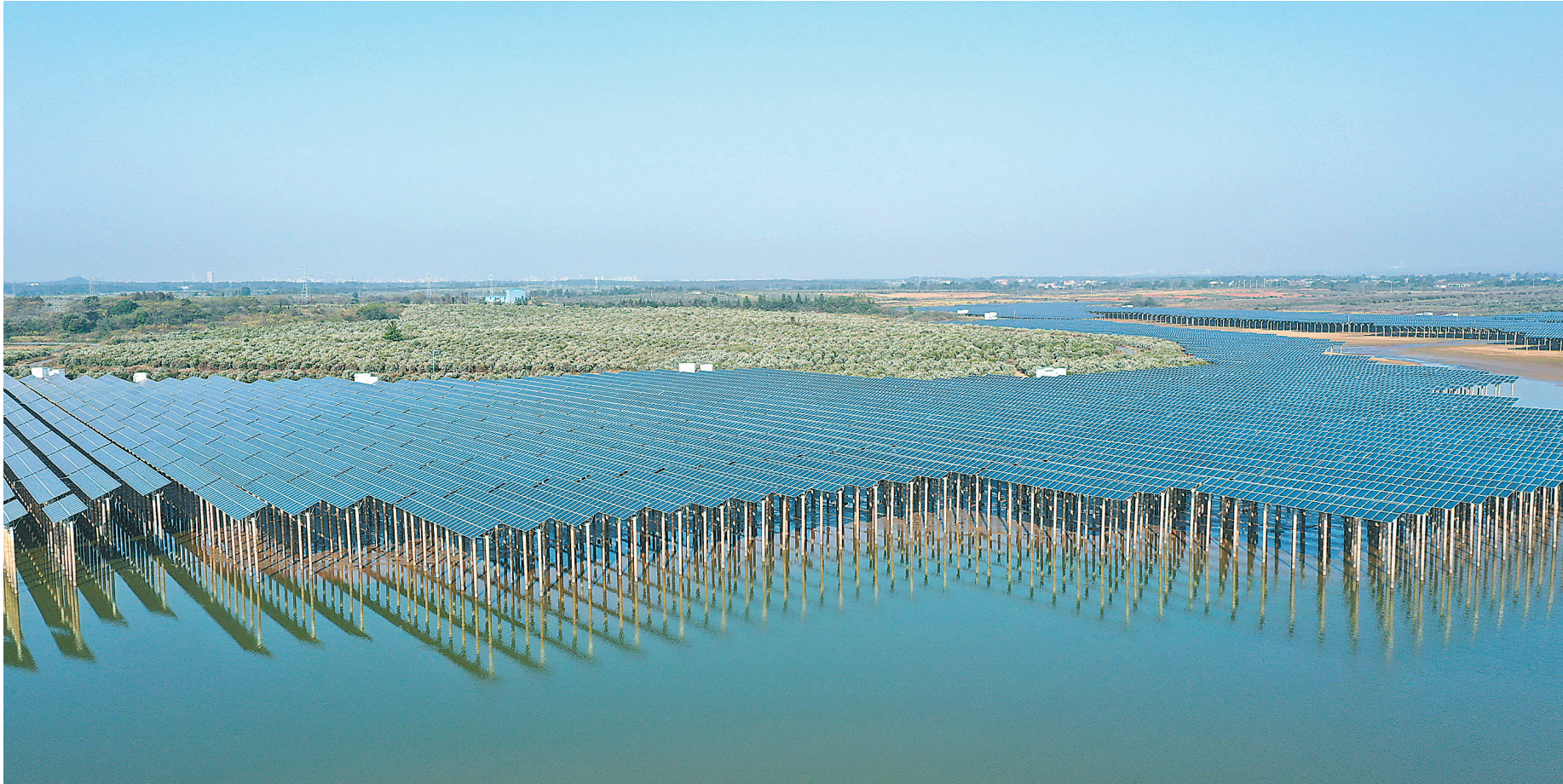
1月15日，乌瞰奉新县宋埠镇和赤田镇境内的跃进水库“渔光互补”发电项目，一排排蓝色光伏面板蔚为壮观。该项目总投资12亿元，总装机容量110兆瓦，上层用于光伏发电，下层用于水产养殖。年发电量9000万千瓦时，相比火力发电，每年可节约标煤2.97万吨，减少大气污染物近10万吨。
