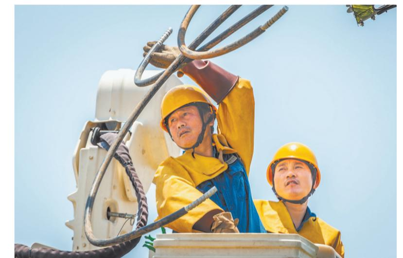
近日,国网江西鹰潭供电公司电力检修工人冒着酷暑,对余江区潢溪镇循环经济园相关线路更换真空开关,确保为27家企业和1241户村民不间断供电。
