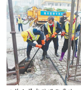
工作人员在疏通化粪池。本报全媒体记者 陈璋摄
