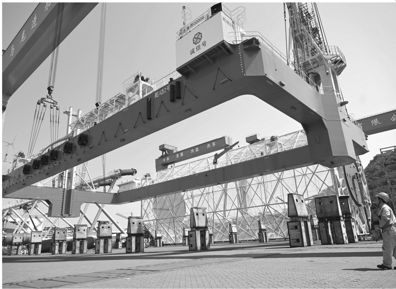
4月9日，工人在指挥吊装“乾动2号”深远海养殖平台。
