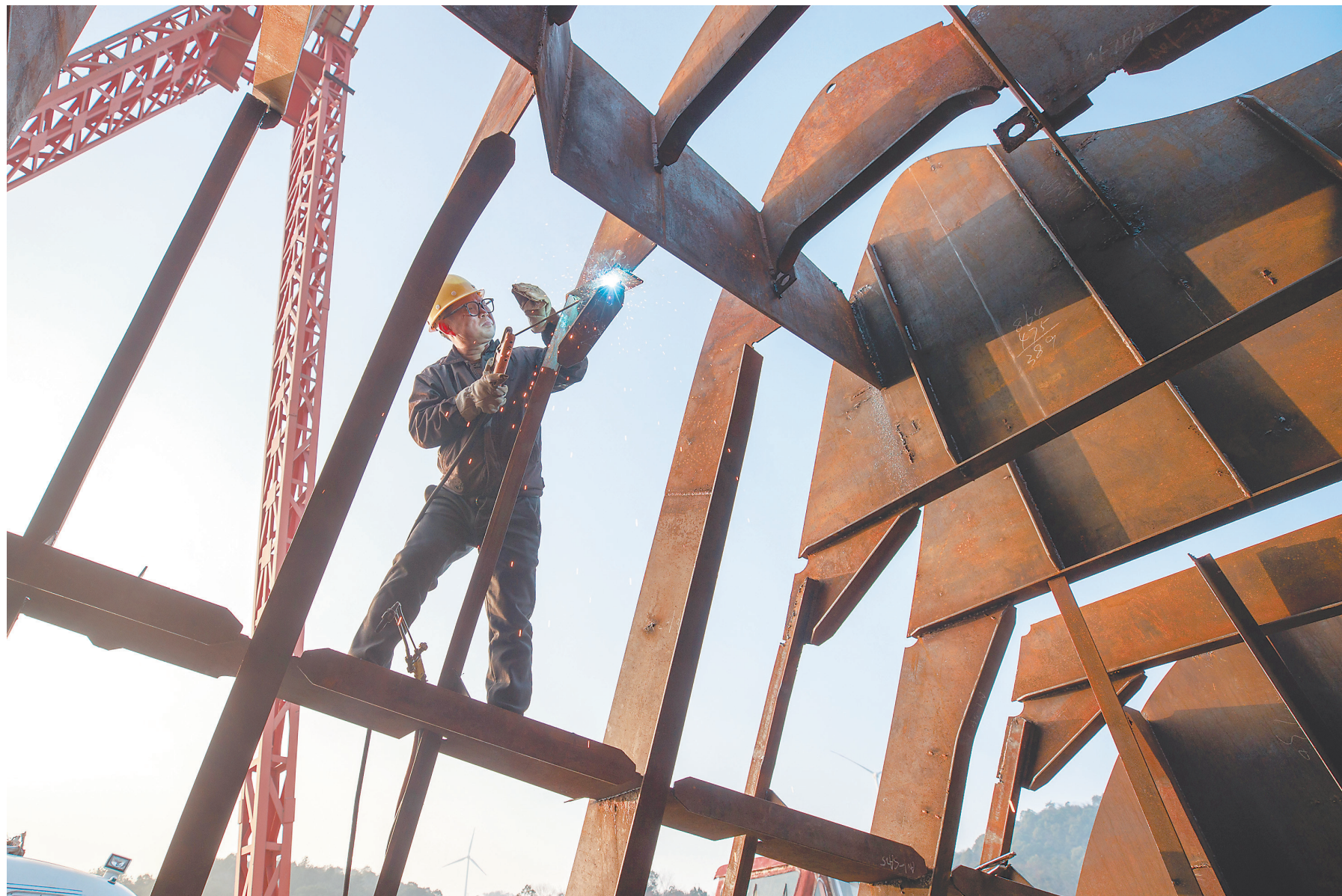
1月3日,鄱阳湖畔的都昌造船总厂,焊工一丝不苟地对船身进行焊接。焊工作为“钢铁裁缝”,必须确保每一条焊缝都零瑕疵。
