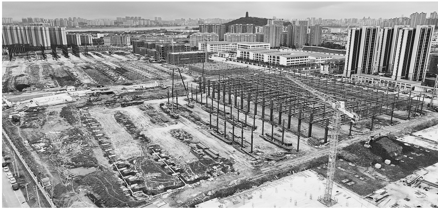
2月22日,吉安市吉州区伊戈尔股份第三代数字供电系统百万项目施工现场,工作人员正在有序施工。今年以来,该区持续统筹推进产业园区基础设施建设,确保一批重大项目如期顺利开工,加快推进产业园区高质量发展。特约通讯员 李军摄
