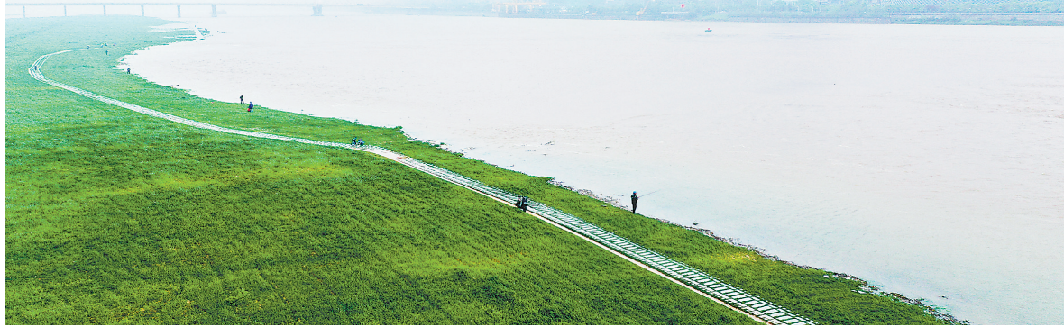
4月4日,赣江南昌袁家洲部分洲滩被江水淹没,整个江面更加宽阔。连日来,受持续降雨影响,赣江南昌段水位持续上涨。据省水文监测中心数据,截至4月4日19时,赣江南昌段水位达19.14米,低于警戒水位3.86米。(本报全媒体记者 史浩洋摄)
