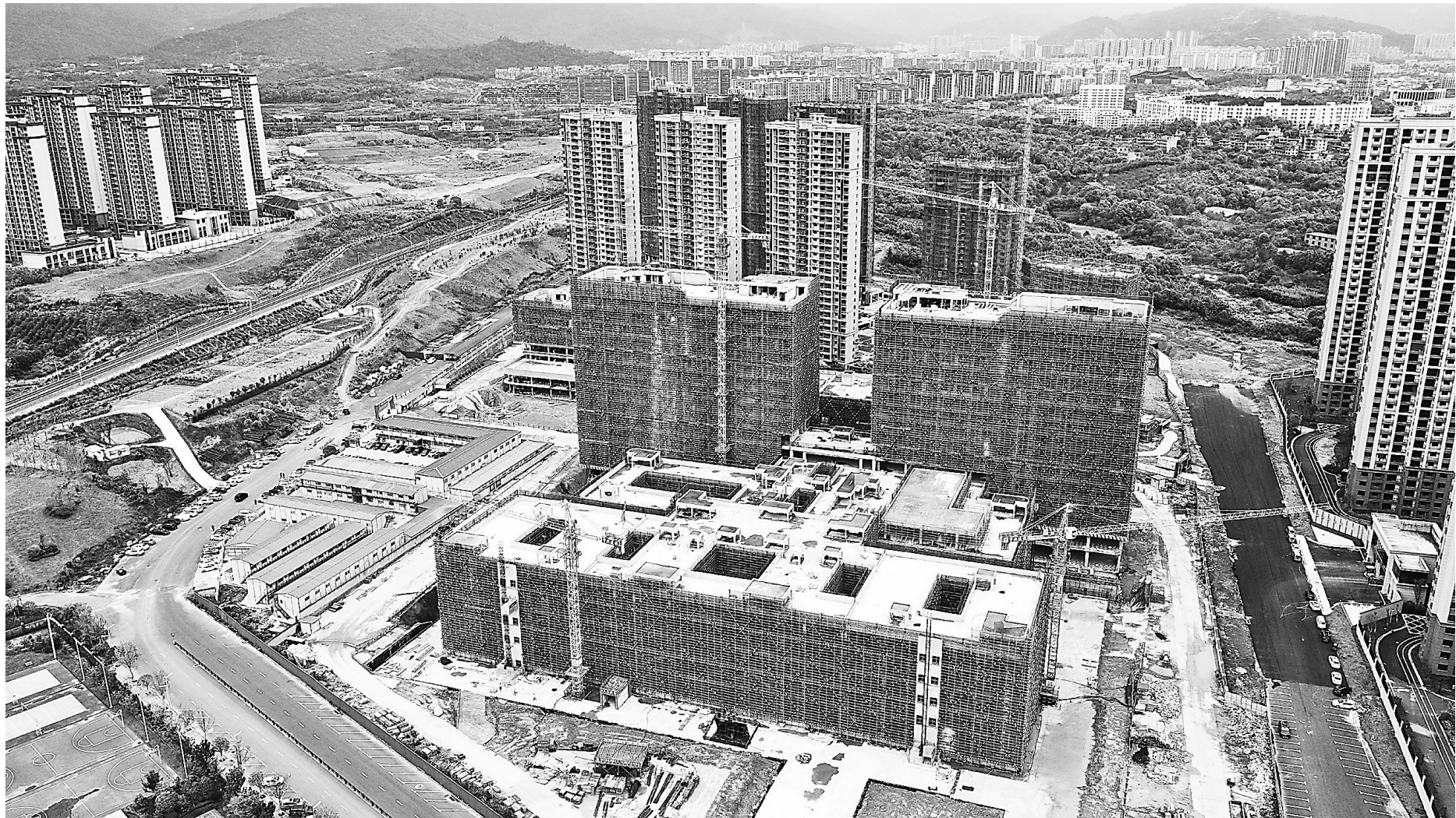
4月1日，南昌大学第二附属医院新建医院项目建设正有序推进。该项目总投资13亿元，占地100.9亩，设计床位765张，预计2026年建成，建成投用后将填补南昌市新建区三甲医院的空白。王蕴蓉摄
