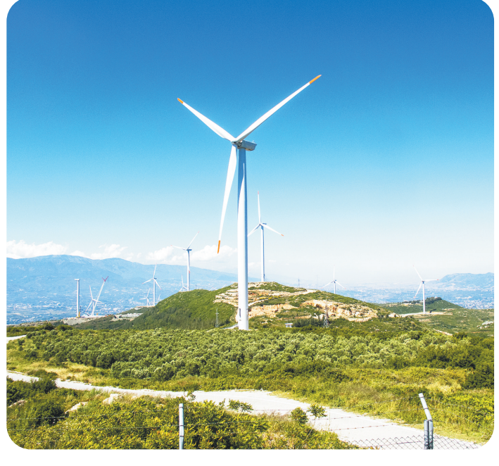
2023年2月,江西中行成功投放全国首笔“碳减排挂钩”风电并购贷款,图为企业风电项目现场。
