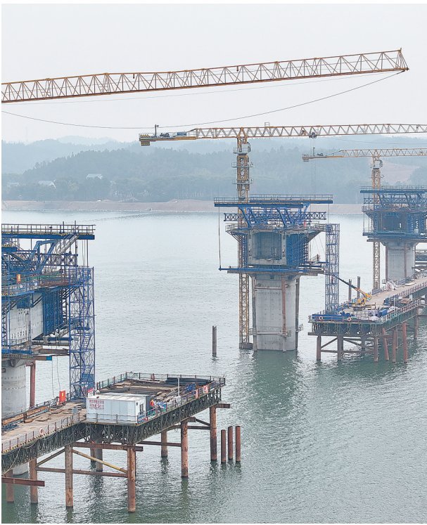
近日，峡江县重点民生项目仁和大桥渡改工程建设正酣。图为施工人员在挂篮作业。本报全媒体记者 吴文兵摄
