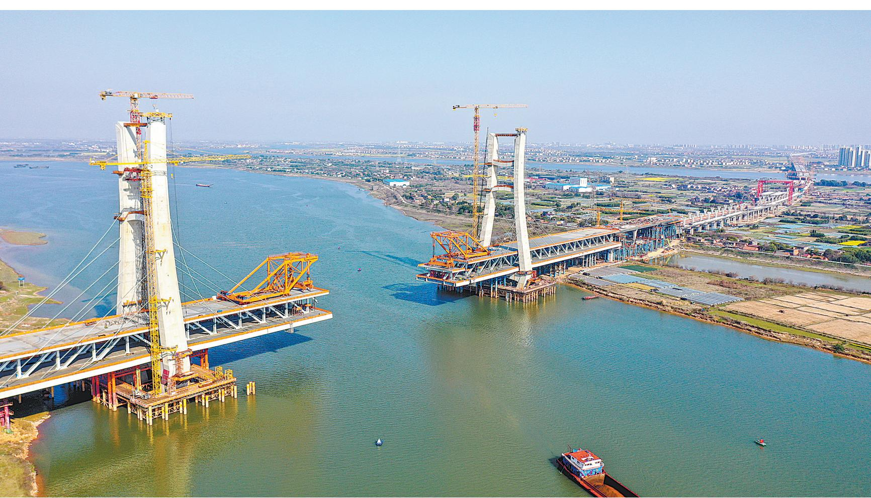
3月19日，南昌市隆兴大桥跨赣江西支主桥建设现场，施工人员正在进行钢梁施工安装。目前，钢梁架设已完成36节，完成率80%，预计今年5月底大桥实现钢梁合龙。
