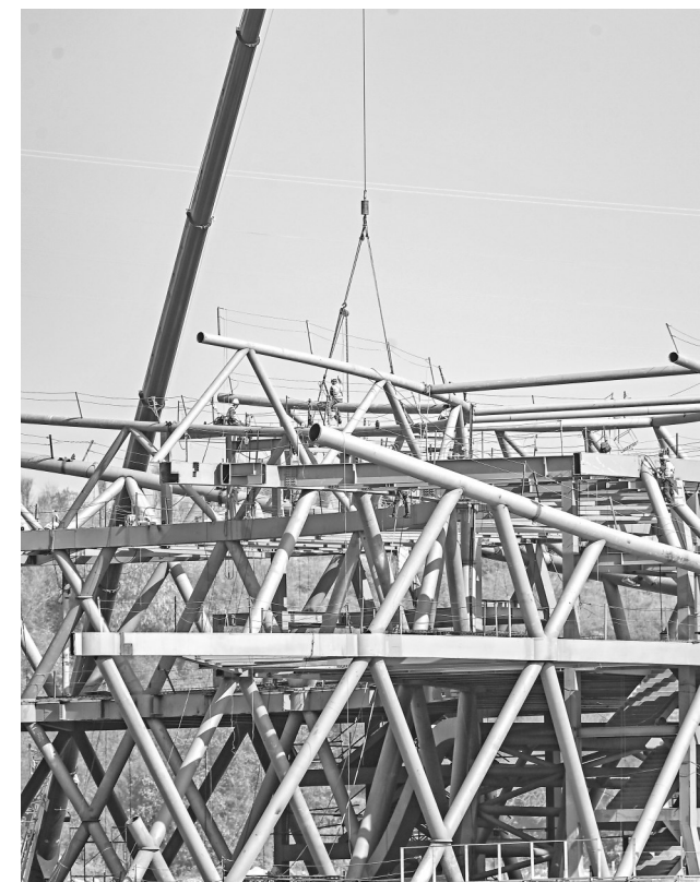
近日，赣州市章贡区水西镇水西老街乡村振兴项目建设现场，施工工人正抓紧作业，推进项目建设。特约通讯员 胡江涛摄
