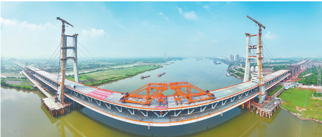
5月1日，昌九高铁控制性工程——昌九高铁扬子洲赣江公铁大桥西支主桥钢梁全部吊装完成，预计本月中旬合龙。
