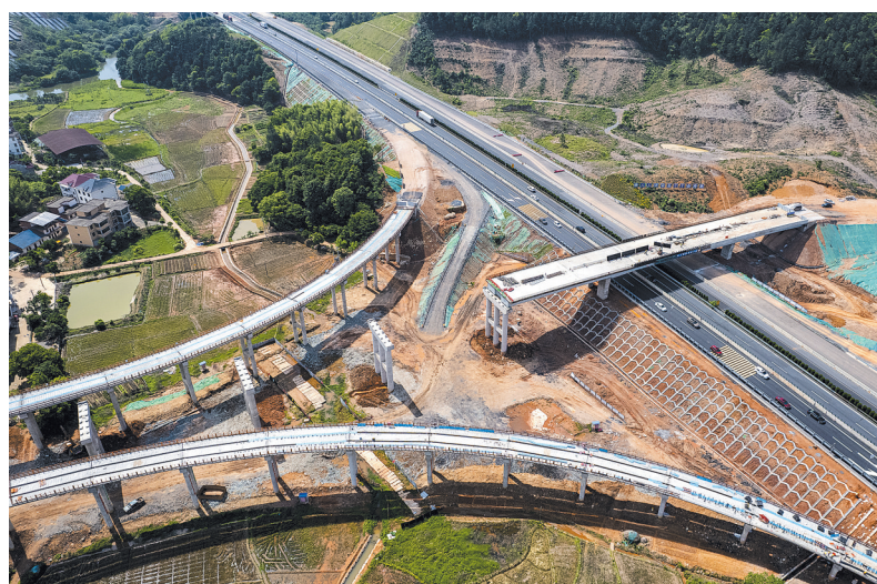
“五一”假期，新余市重大项目施工现场，众多劳动者坚守岗位。图为5月2日，沪昆高速改扩建项目新余互通施工现场，工人正在紧张施工。
