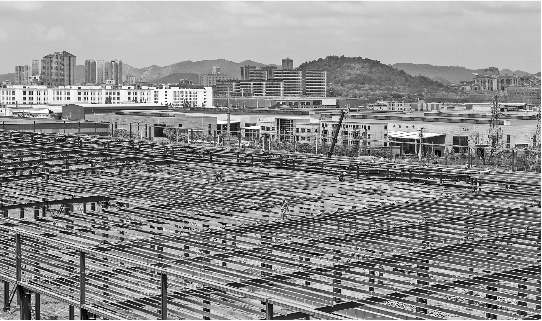
5月2日，在位于分宜工业园区的新冶新材料报废汽车回收拆解项目建设现场，工人正在建设钢结构厂房。该项目投资3.9亿元，建成后每年可精细化拆解10万辆报废机动车，实现报废机动车金属类、橡胶类及其他零部件的再制造再利用。 本报全媒体记者 邹宇波摄
