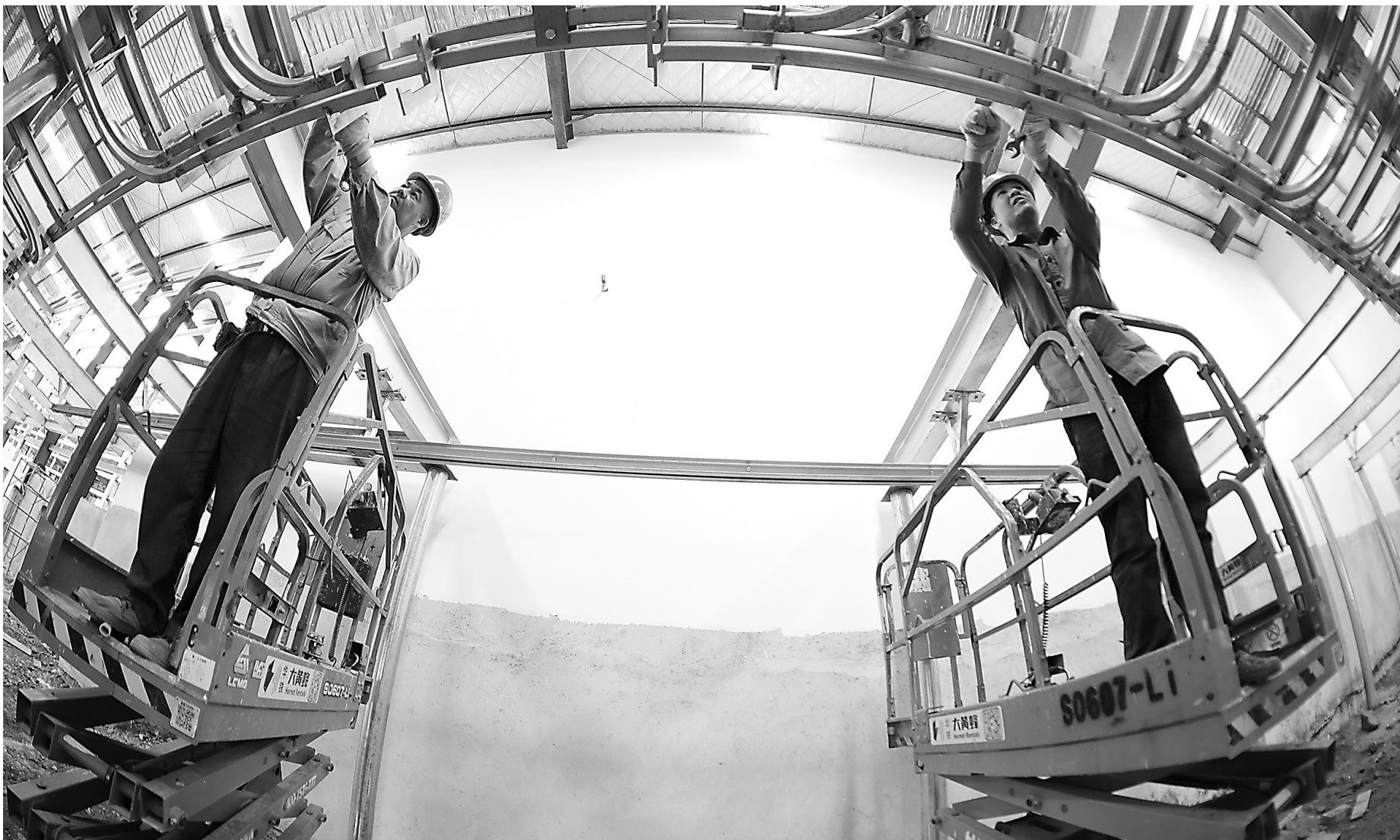
位于会昌县麻洲镇的赣州盛安食品有限公司总投资3.9亿元,是该县首个自动化、智能化的屠宰加工企业。图为近日,工人在项目建设现场安装设备。
