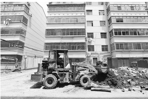
近年来，抚州市东乡区大力实施老旧小区改造工程，提升居民生活品质。图为5月7日，金峰街道老旧小区改造现场，工人正在施工，准备埋设雨污分流管道。 特约通讯员 饶方其摄
