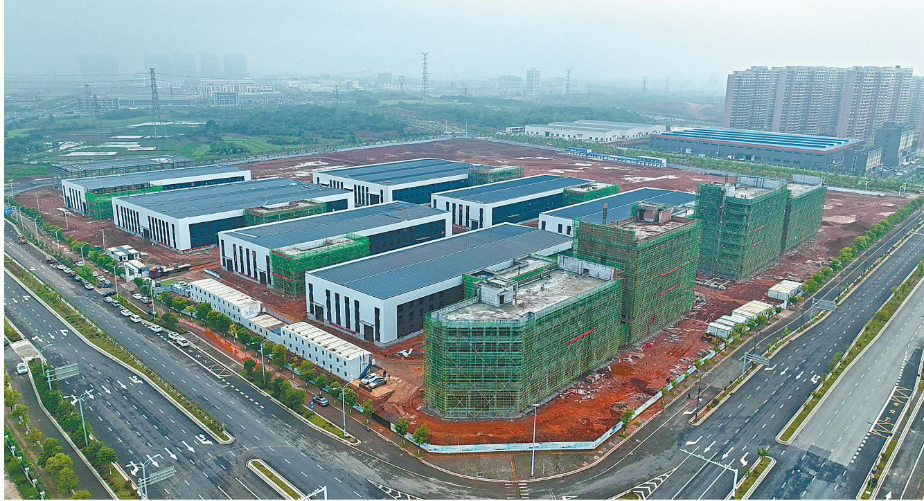
图为建设中的南昌万景装备制造产业园。(新建区融媒体中心供图)
