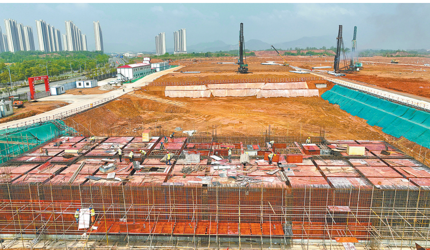
图为施工中的赣锋锂电(南昌)锂电池生产基地。(新建区融媒体中心供图)
